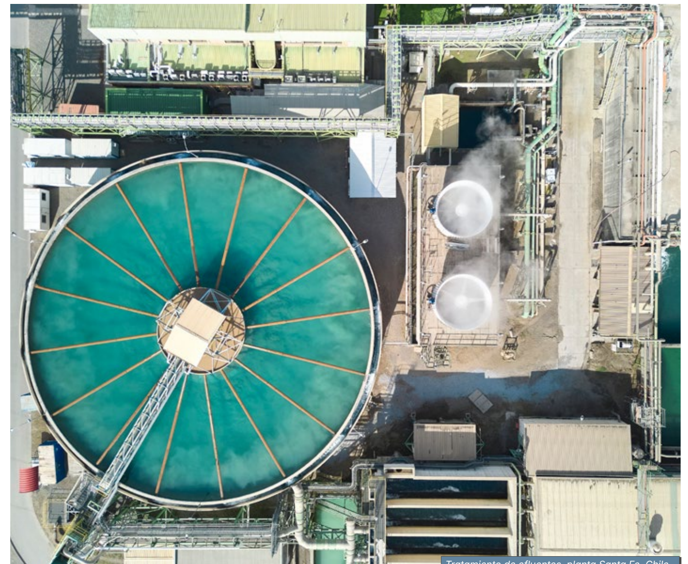
Tratamiento de efluentes, planta Santa Fe, Chile.
